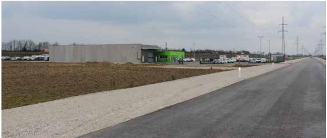
Das Gewerbegebiet Wimpassing ist bereits fast gänzlich durch die WBA verwertet.
