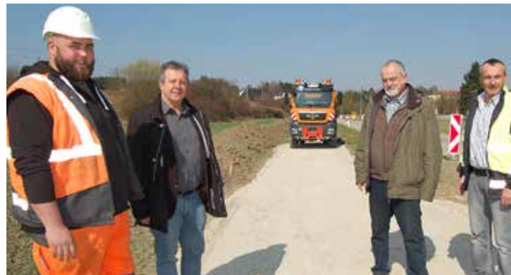
Verkehrsstadtrat Klaus Hoflehner besichtigt die Baustelle in Niederthan.
