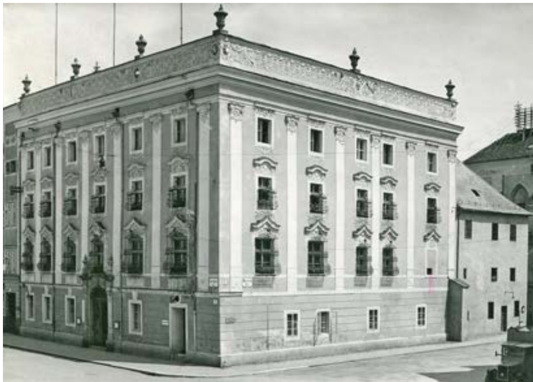
Das Rathaus in den späten 1930er-Jahren, rechts das 1963 abgerissene „Gerichtsdienerstöckl“.
