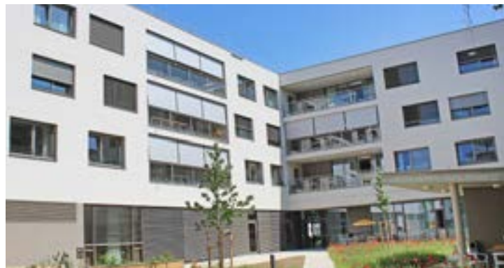
Größte Investition 2017: Der Neubau des Hauses Leopold Spitzer. In der Hans-Sachs-Straße 22 steht nun das modernste Welsere Seniorenheim.
