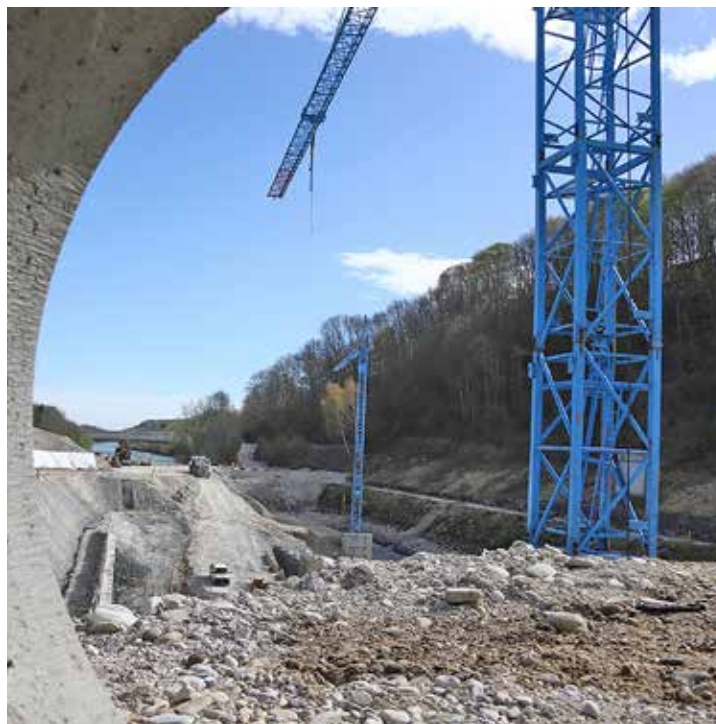
Die Arbeiten beim neuen Kraftwerk in Traunleiten gehen zügig voran.
