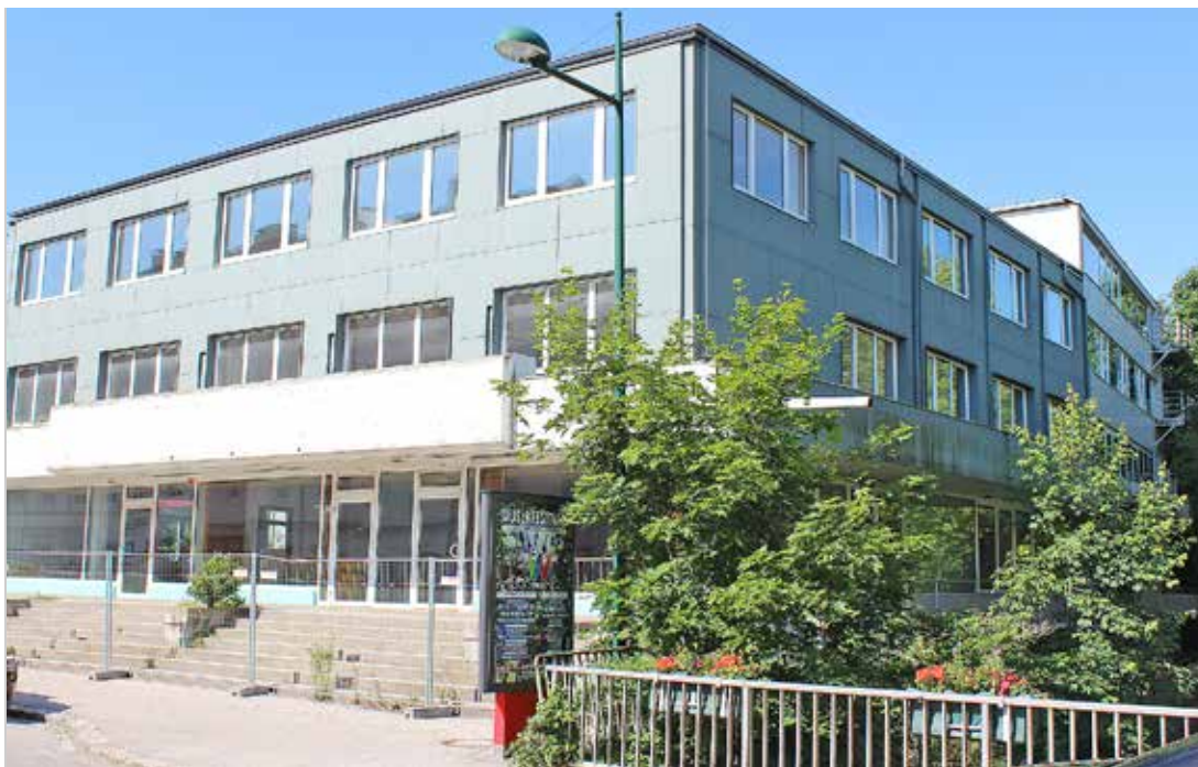
Dieser Blick von der Traungasse Richtung Volksgartenstraße/Mühlbach gehört bald der Vergangenheit an.
