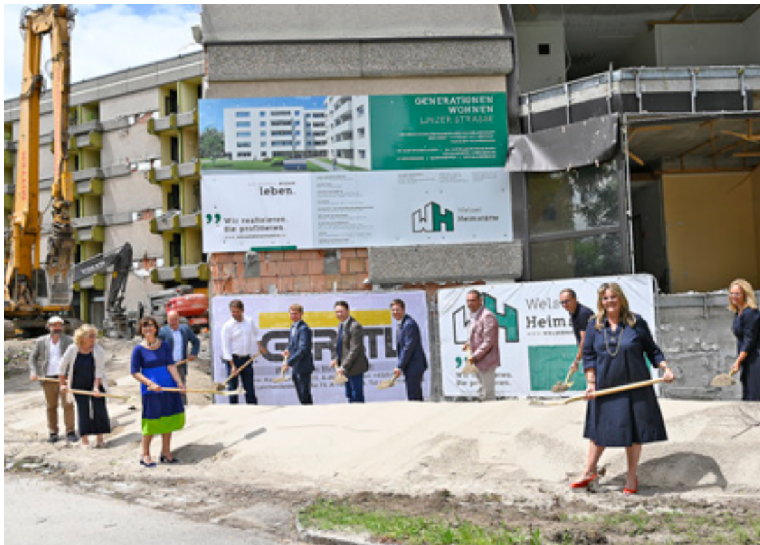
Anfang Juli erfolgte der Spatenstich für das Generationenwohnen in der Linzer Straße.
