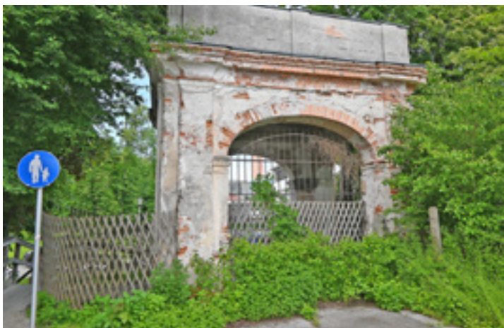
Nach der Sanierung soll der Torbogen für Fußgänger begehbar sein.
