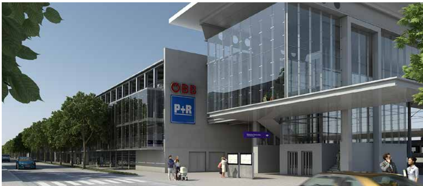
Mit rund 2,8 Mio. Euro beteiligt sich die Stadt Wels an der dringend nötigen Errichtung des ÖBB-Parkdecks in der Neustadt.
