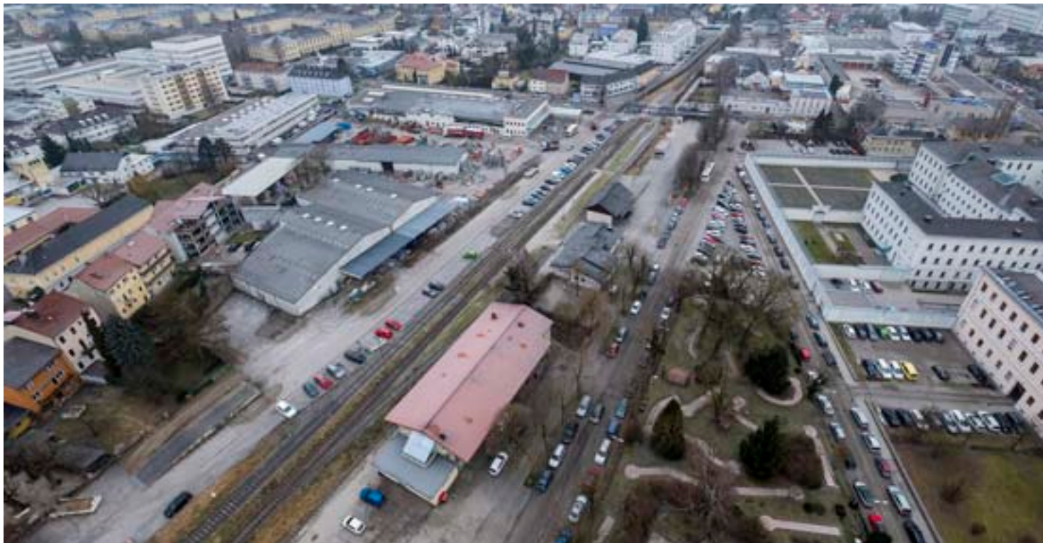
Aktuelle Ansicht des Lokalbahnhofes mit Blickrichtung Dragonerstraße. Historische Aufnahmen sind auf den folgenden Seiten zu sehen.
