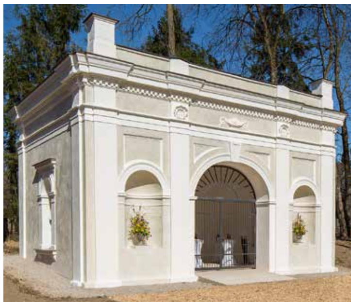
Der restaurierte Sisi-Pavillon im Schlosspark Lichtenegg.
