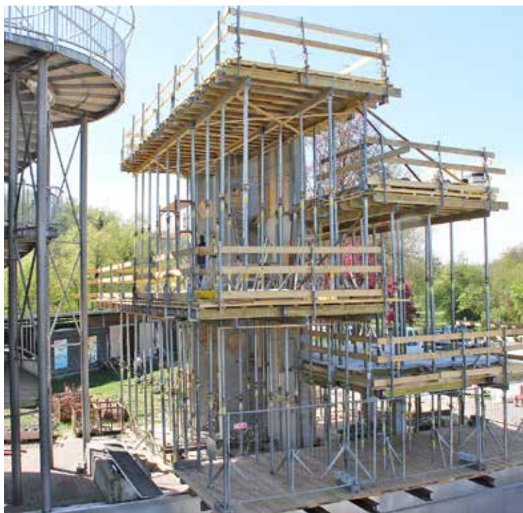
Weiter in die Höhe wächst der Sprungturm im Welldorado. Bis zur geplanten Eröffnung des Freibads Ende Mai werden alle Arbeiten fertiggestellt sein. Einem Sprung ins kühle Nass sollte dann nichts mehr im Weg stehen.
