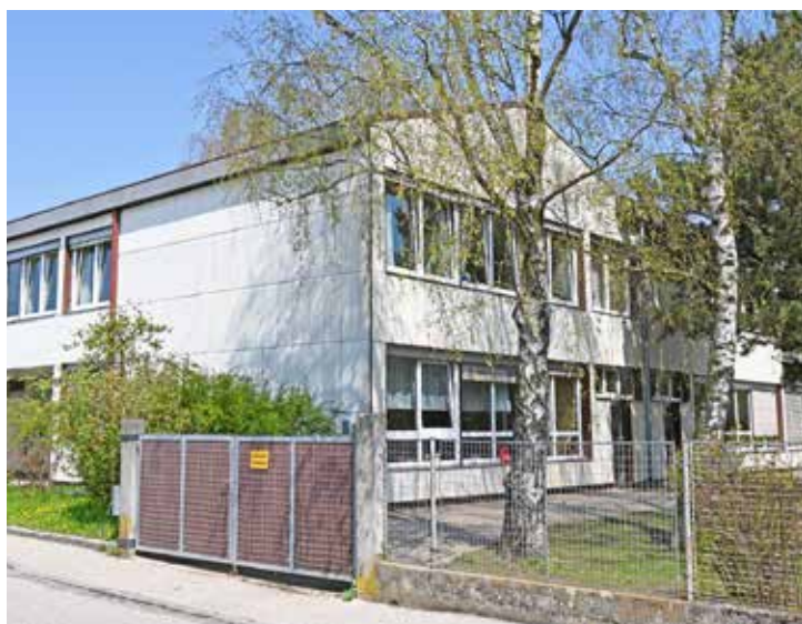
Diese Ansicht des alten Kindergartens Lessingstraße wird bald der Vergangenheit angehören: Das 1961 errichtete Gebäude wird abgerissen.
