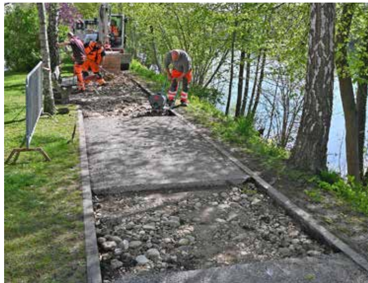
Auf diesem Foto wird noch an der Treppelwegverbesserung gearbeitet.
