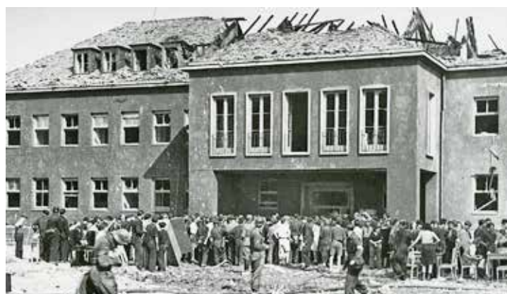
...und hier das ebenso beschädigte Verwaltungsgebäude.
