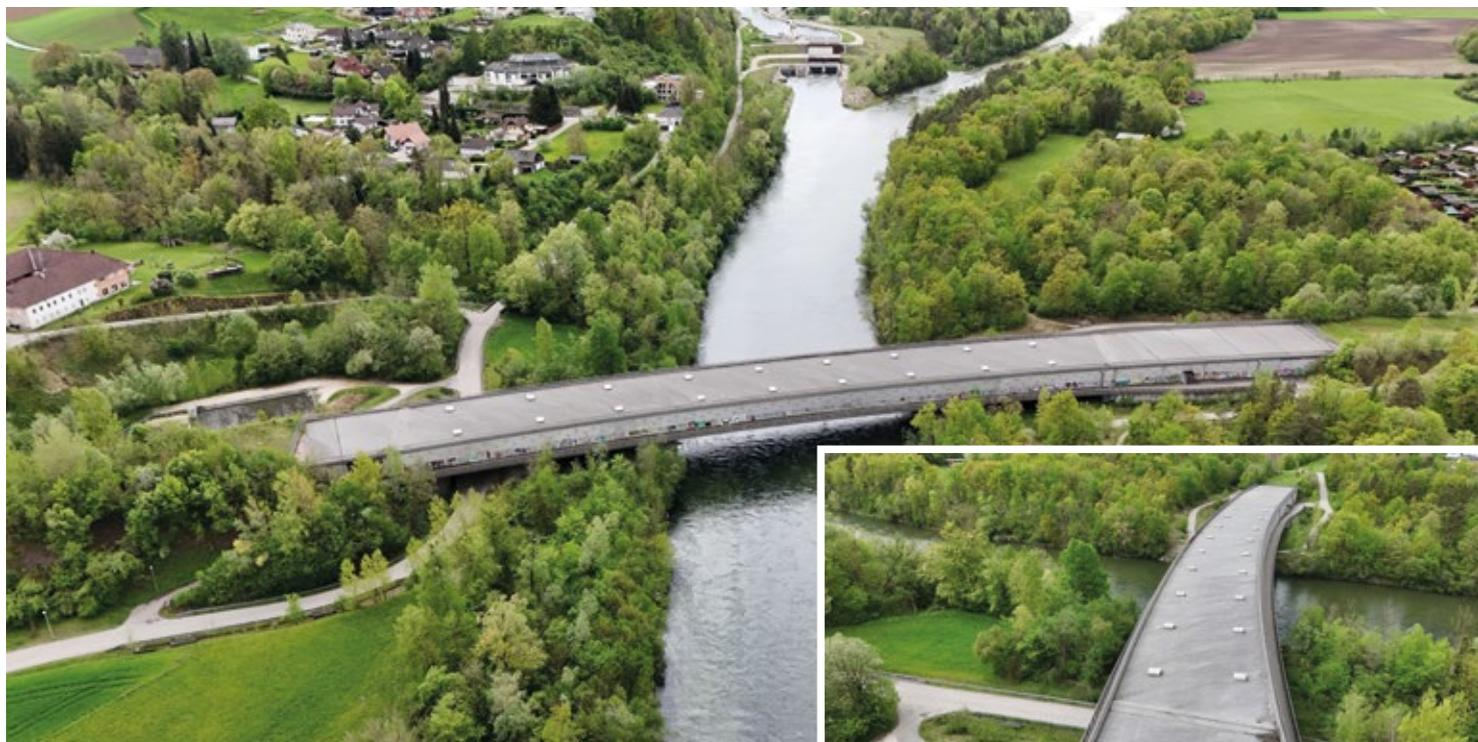
Bei der ASFINAG wird der Übergang der A8 Innkreis Autobahn unter der Bezeichnung „Traunbrücke J122“ geführt. Der Kraftverkehr ist samt Lärm und Abgasen im Tunnel versteckt, während der Geh- und Radverkehr (Almtalradweg R11) an der Außenseite verläuft.
